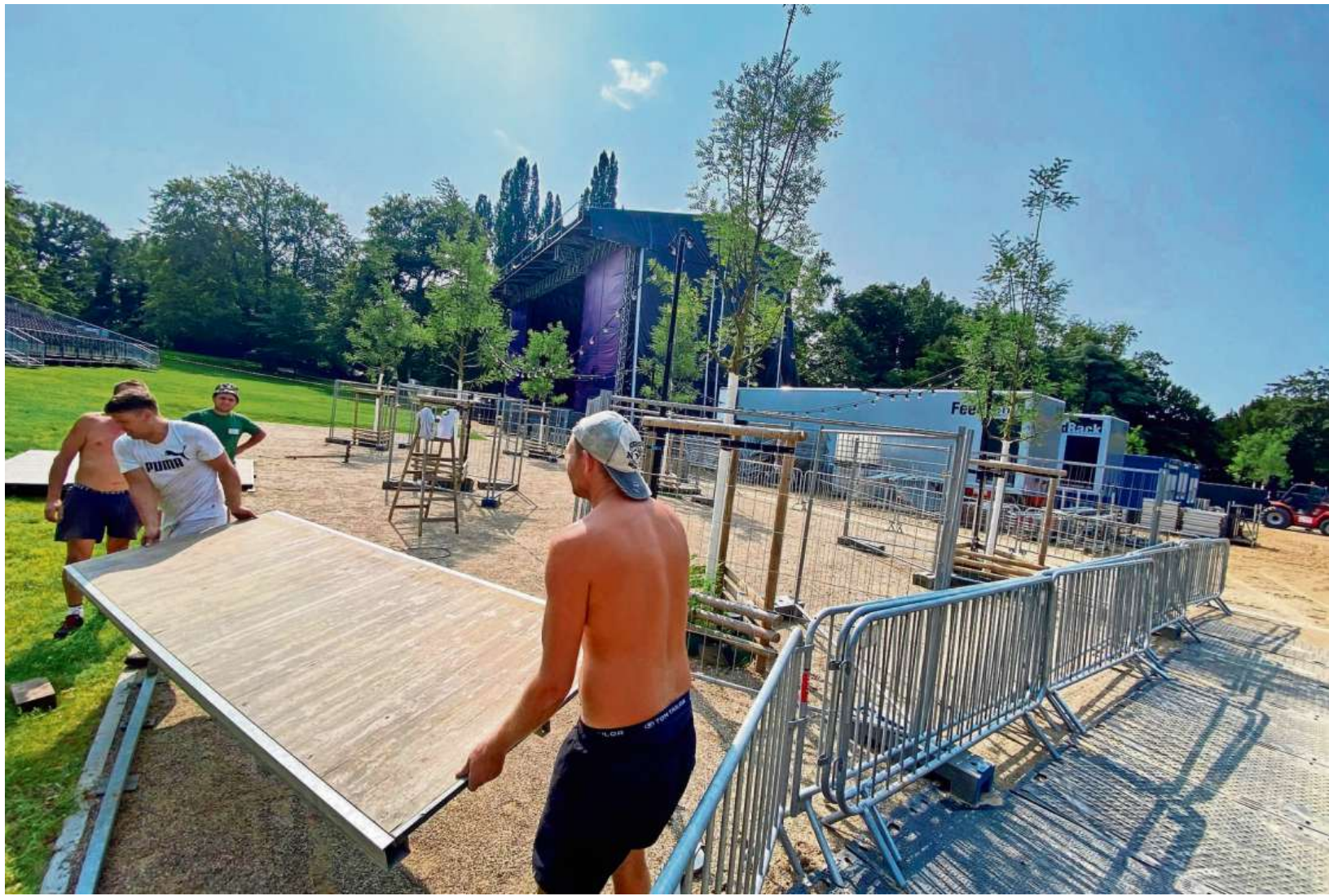
Über 1700 Quadratmeter des Kurparks werden mit Extra-Boden überbaut, um den Untergrund zu schützen – und die neuen Bäumchen am Rande. FOTOS: ROBERT ESSER
